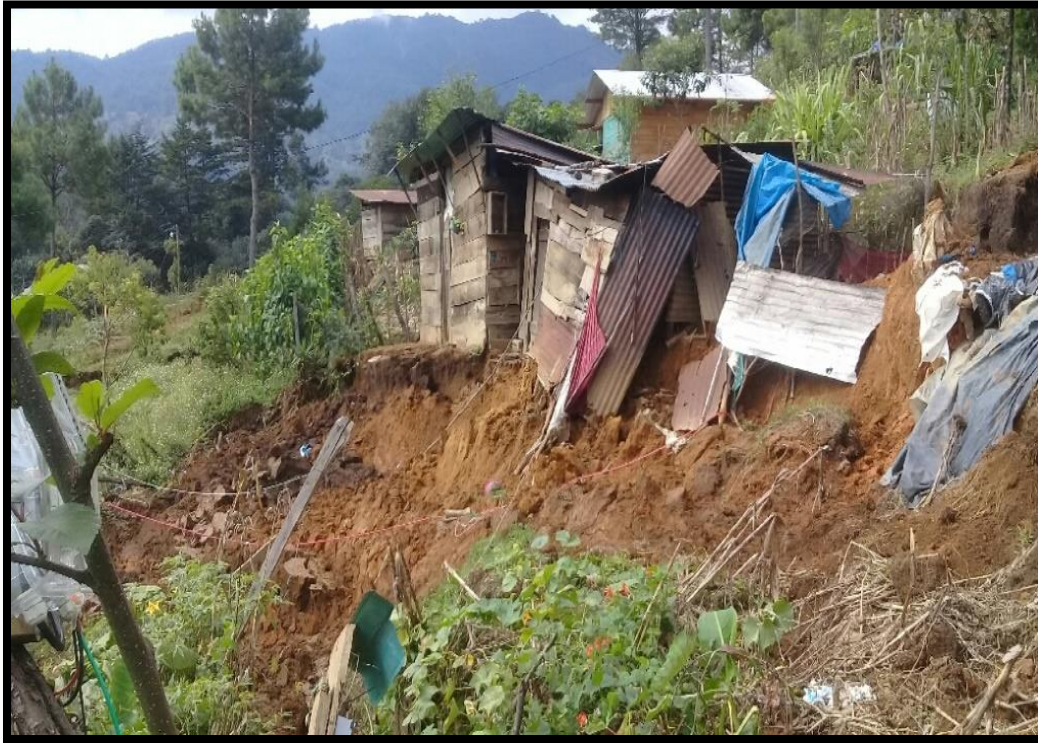
Ilustración 3. Casa destruida en comunidad Xexuxcap Acul Nebaj
