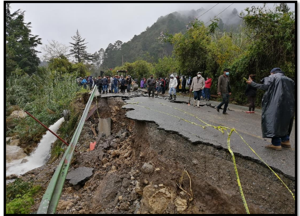
Tramo de carretera colapsada de la salida del municipio de Santa María Nebaj a Santa Cruz del Quiche, RUTA RD-QUI-030-01, Estación 303+200
