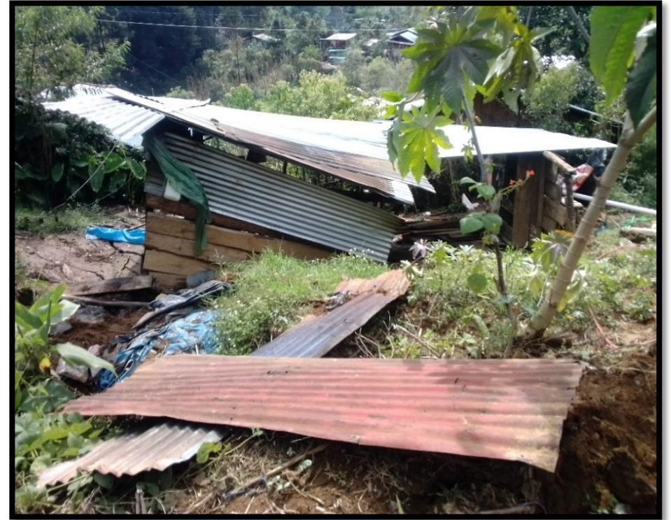
Ilustración 4 Casa destruida por deslave en la pista Nebaj
