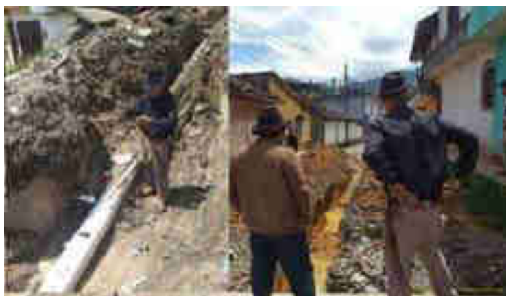
CONEXIÓN DE AGUA Y DRENAJE EN CANTÓN VICUATYÁ - XOLACUL
