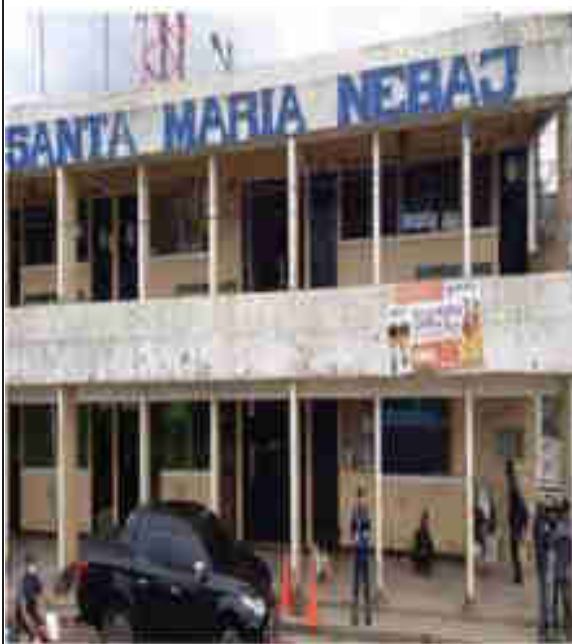
Fotografía mes de febrero resguardo del edificio Municipal
