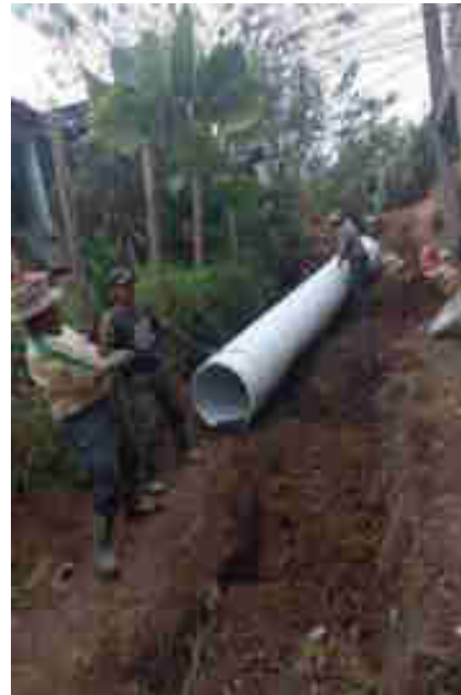
REPARACIÓN SISTEMA DE DRENAJE EN TU SALINA
