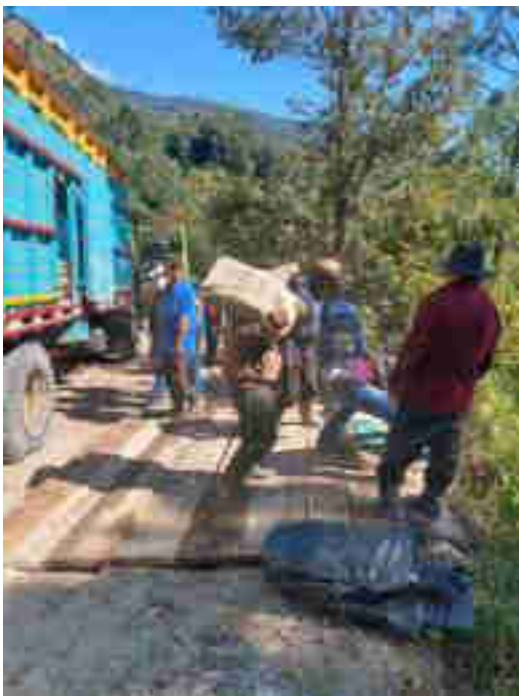
Apoyos materiales de construcción para pavimento (camino rural) Aldea Parramos Grande, Nebaj Quiche.
