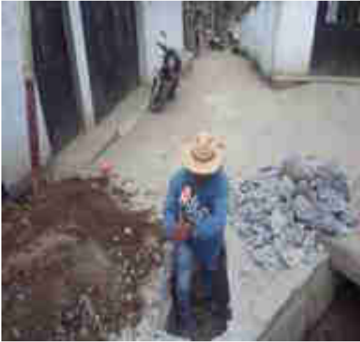
REPARACIÓN SISTEMA DE AGUA EN SIMOCOL
