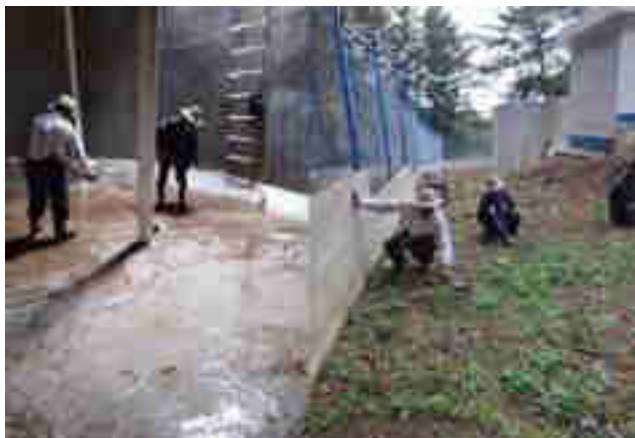
LIMPIEZA TANQUE DE DISTRIBUCIÓN DE SIVAN JOO
