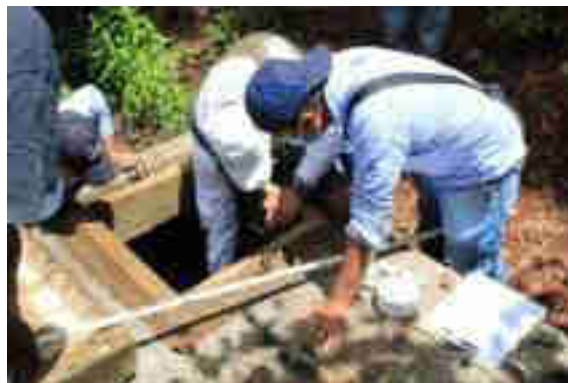
VERIFICACION DE CAUDAL DE AGUA
