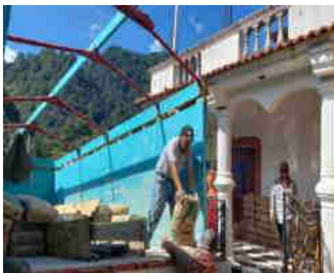
Apoyos materiales de construcción para la Aldea Xexuxcap, Nebaj Quiche.
