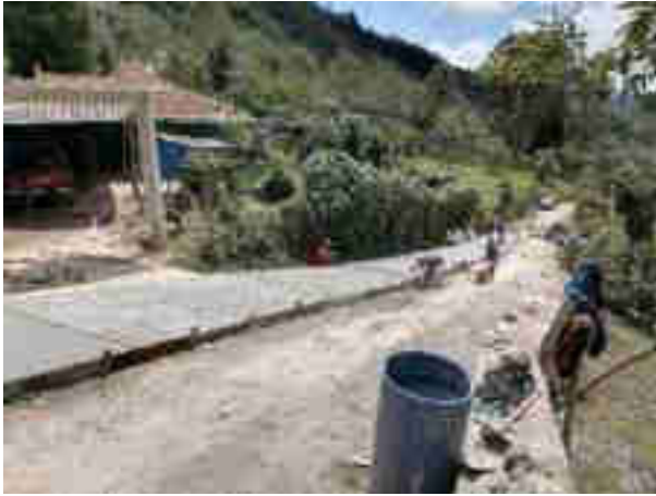
Pavimentación aldea Xoloche, Nebaj, Quiché.
