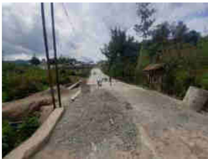
Pavimentación cantón Salquilito hacia cantón La Laguna, Nebaj, Quiché.
