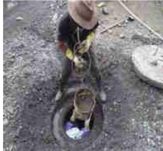
REPARACIÓN DE SISTEMA DE DRENAJE EN XEMAMATZÉ
