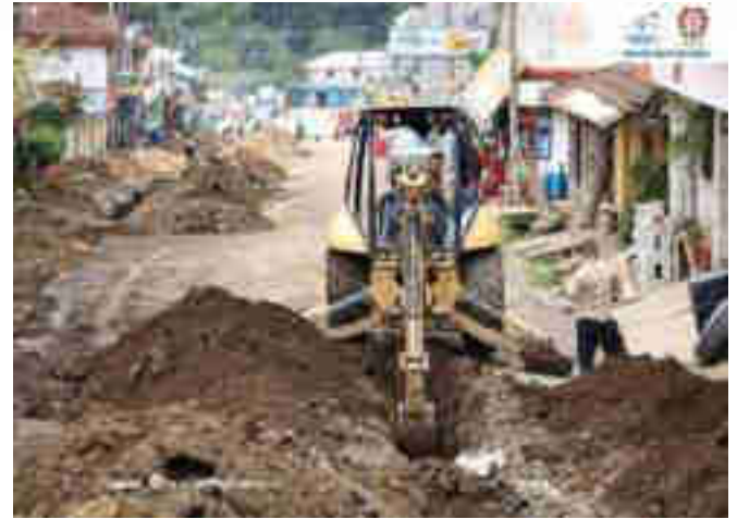
Arrendamiento de maquinaria para reparación y mantenimiento de drenaje aldea Acul, Nebaj Quiche.
