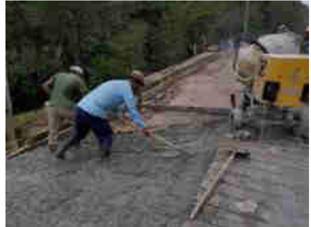
Pavimentación aldea Xoloche, Nebaj, Quiché.
