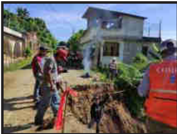
Evaluación de daños por un deslizamiento de carretera de la Aldea Sumalito, Nebaj, Quiché.
