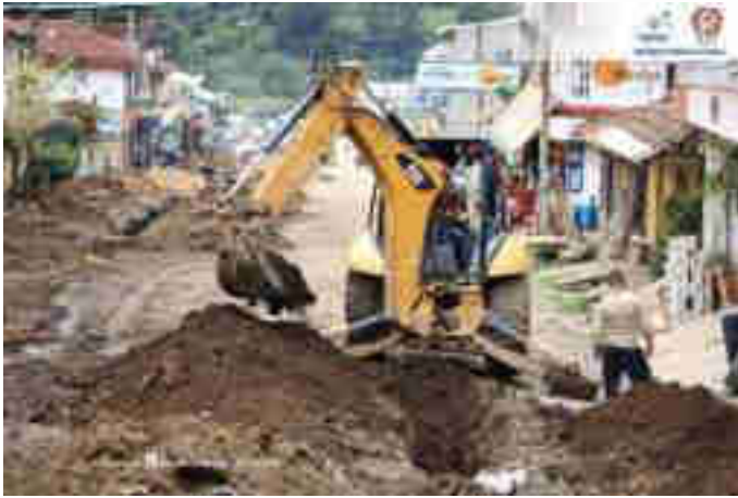
Arrendamiento de maquinaria para reparación y mantenimiento de drenaje aldea Acul, Nebaj Quiche.
