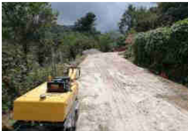
Conformación de base de pavimentación, aldea Xoloche, Nebaj, Quiché.
