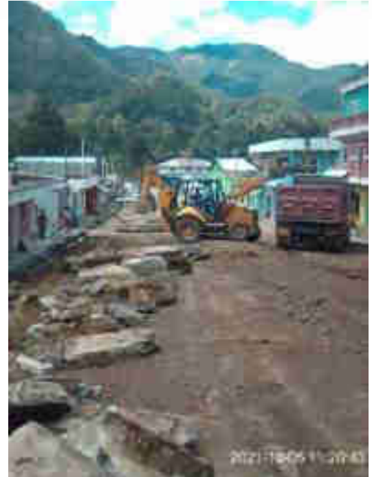
MONITOREO DE PROYECTO MEJORAMIENTO CALLE PRINCIPAL ALDEA ACUL
