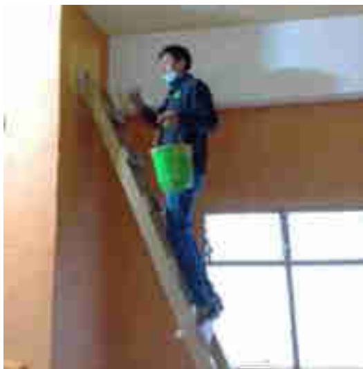
LIMPIEZA Y PINTADA DE LOS SALONES DEL EDIFICIO DEL CANTÓN XOLACUL PARA FUNCIONAMIENTO DE FUNDAP
