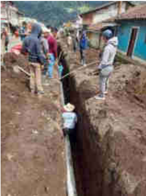
CONEXIONES DE DRENAJE EN LA CALZADA PRINCIPAL DE LA ACUL
