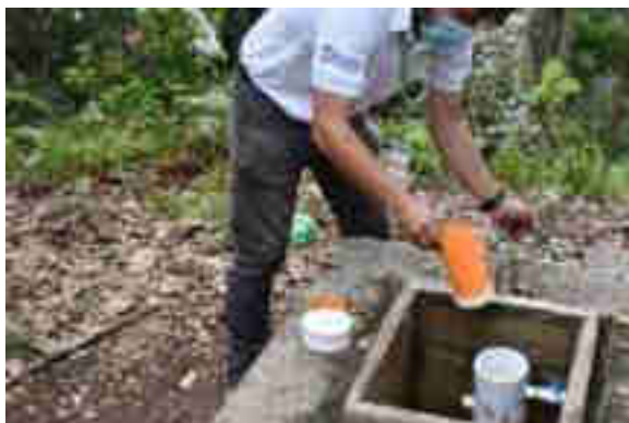
INSTALACION DE CLORADOR ARTESANAL
