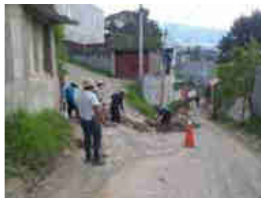
REPARACIÓN DE AGUA EN TU MANZANO
