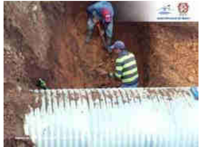
Construcción sistema de aguas pluviales (drenaje pluvial) ruta a aldea Sumalito, Nebaj Quiche
