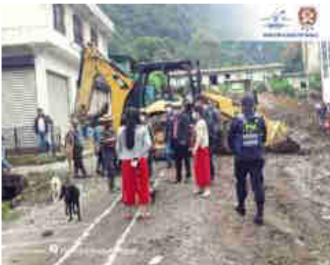
Arrendamiento de maquinaria para reparación y mantenimiento de drenaje aldea Acul, Nebaj Quiche.
