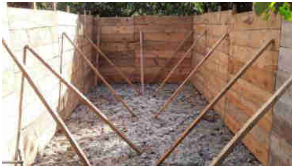
Construcción sistema de agua potable Aldea Belén, Nebaj, Quiche
