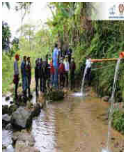
APERTURA DE PROYECTO CONSTRUCCIÓN SISTEMA DE AGUA POTABLE (BELEN)
