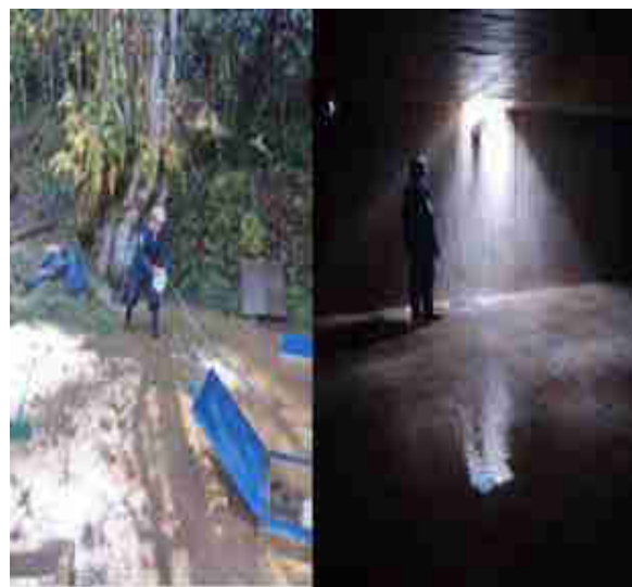
LIMPIEZA NACIMIENTO, TANQUE DE CAPTACIÓN Y DISTRIBUCIÓN XE' KA' MICH - PUO'R'AI
