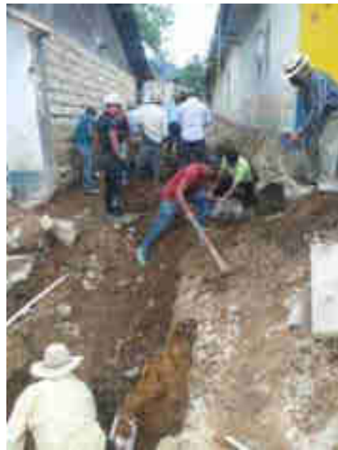
REPARACIÓN DE SISTEMA DE AGUA Y DRENAJE EN BATZBACÁ
