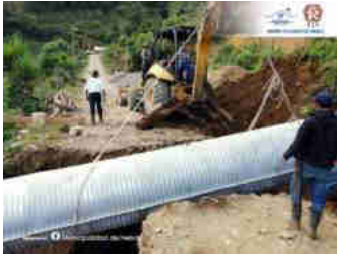
Construcción sistema de aguas pluviales (drenaje pluvial) ruta a aldea Sumalito, Nebaj Quiche
