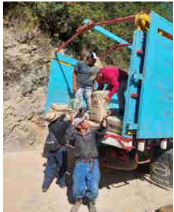
Apoyos materiales de construcción para pavimento (camino rural) Aldea Parramos Grande, Nebaj Quiche.
