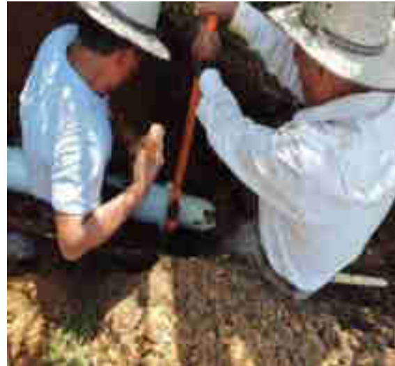
REPARACION DE SISTEMA DE AGUA EN VIXAJ
