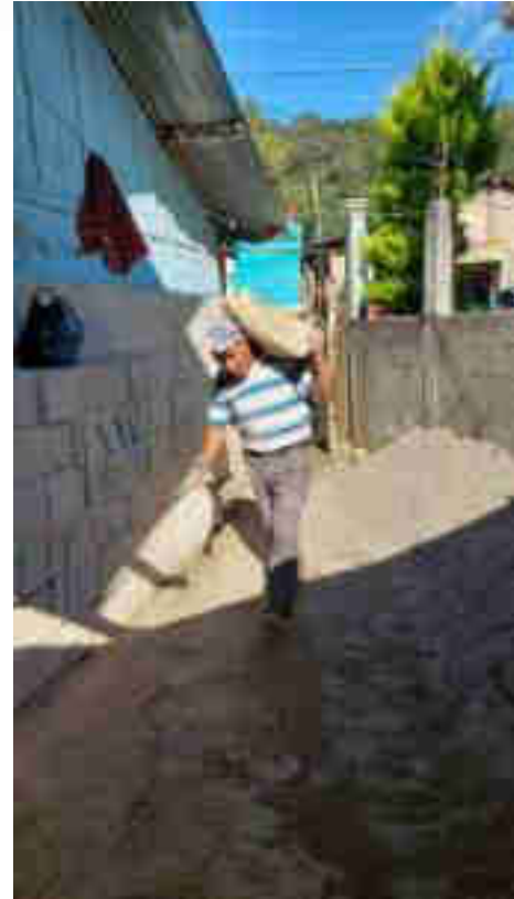
Apoyos materiales de construcción para la Aldea Xexuxcap, Nebaj Quiche.
