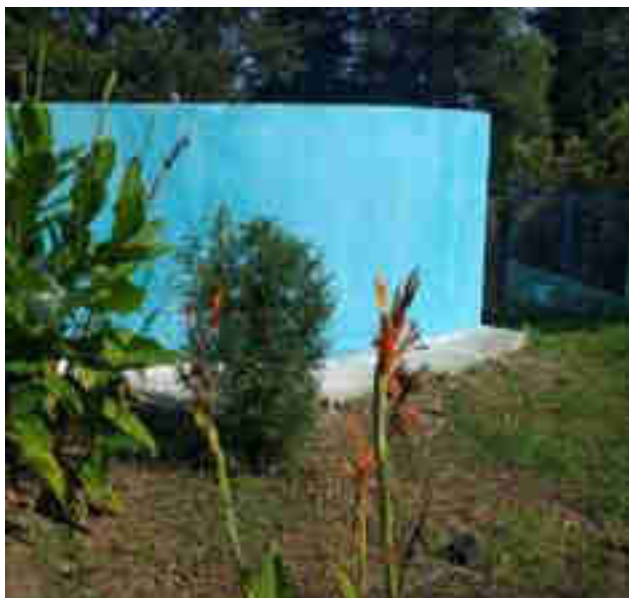
PINTURA TANQUE CIRCULAR DE DISTRIBUCIÓN DEL SISTEMA DE AGUA DE SIVAN JOO
