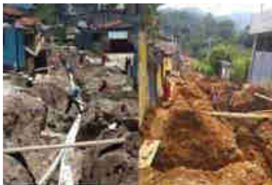
CONEXIONES DE AGUA Y DRENAJE EN JACTZAL-TU RASTRO
