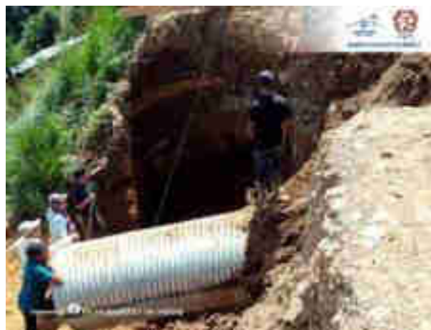
Construcción sistema de aguas pluviales (drenaje pluvial) ruta a aldea Sumalito, Nebaj Quiche
